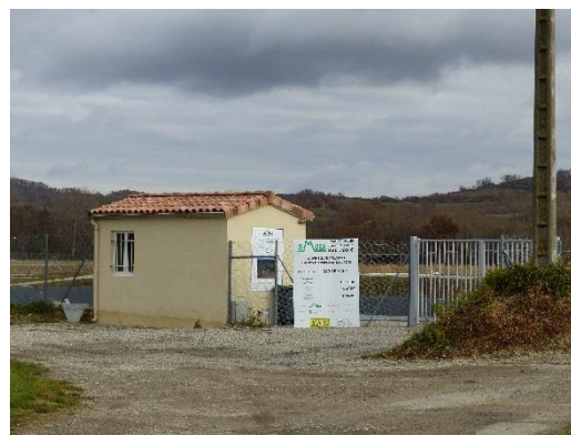
Station d'épuration de Saint-Amadou (640 m)
