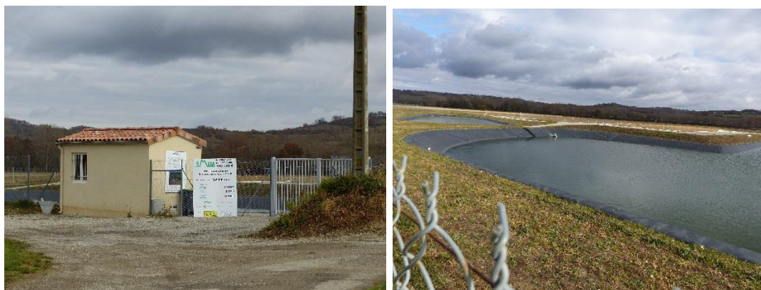
Bassins de lagunage de la STEP de Saint-Amadou
